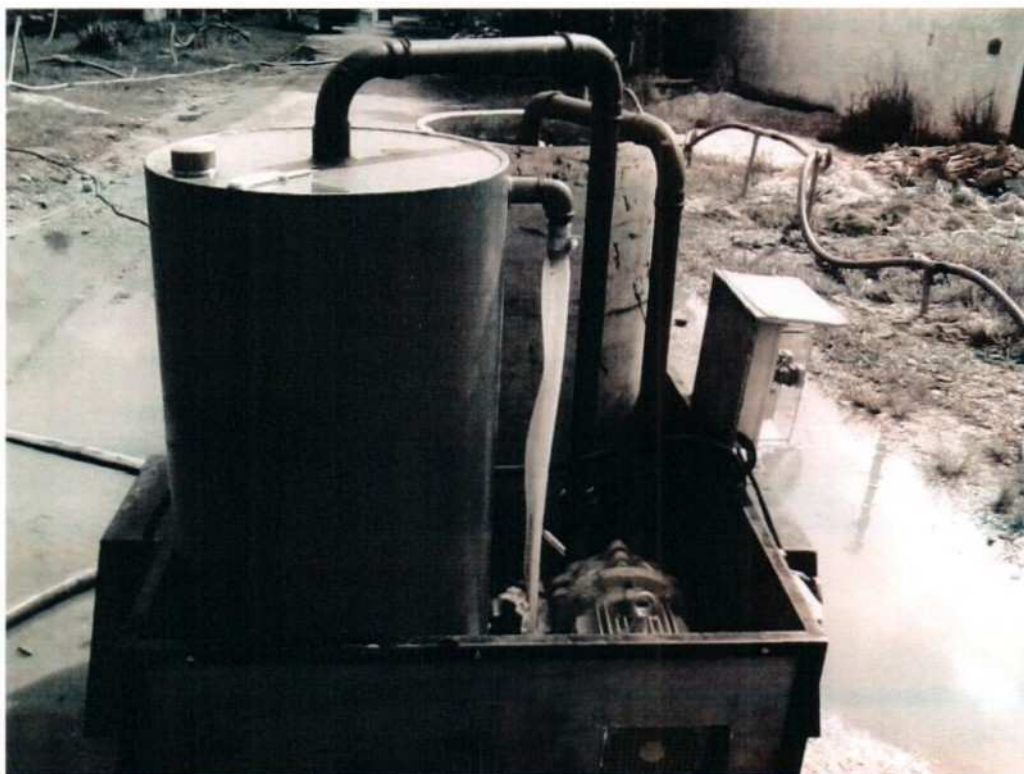
Figura 3.1: Detalhe do Sistema de Rebaixamento "à vácuo"
