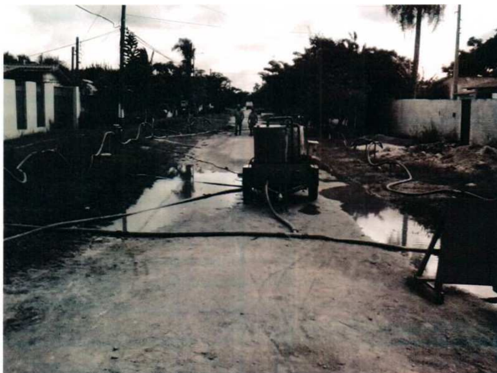
Figura 3.2: Sistema de Rebaixamento "à vácuo"
